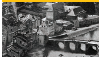
LE PONT DE LIÈGE
